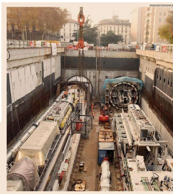
Grandi appalti in caduta. Trend negativo delle gare bandite nel 2018 per le opere sopra i 50 milioni (-4,7%). Nella foto un cantiere della metro M4 di Milano
